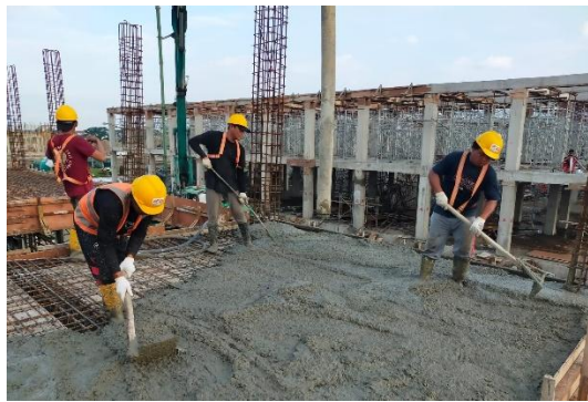
Gambar 2. Aktivitas Pengecoran Pelat Lantai pada Proyek Sekolah XY di Medan
