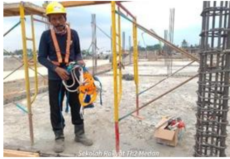
Gambar 3. Pekerja Menggunakan APD di Area Proyek Sumber: Dokumentasi pribadi
