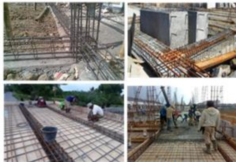
(b) Penggunaan kawat pada konstruksi
